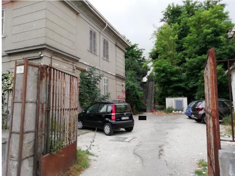
Foto 2 – scala di collegamento da Corso Europa all'interno dell'ex edificio ferroviari.
