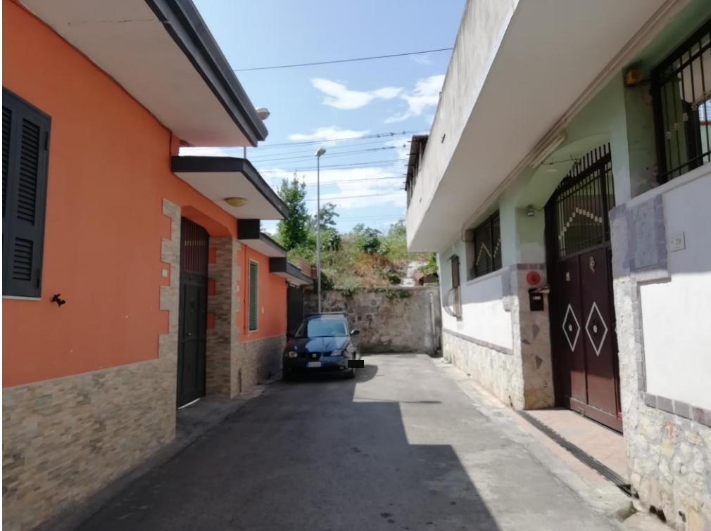
Foto 1 – vista del terrapieno ferroviario in via Garigliano
