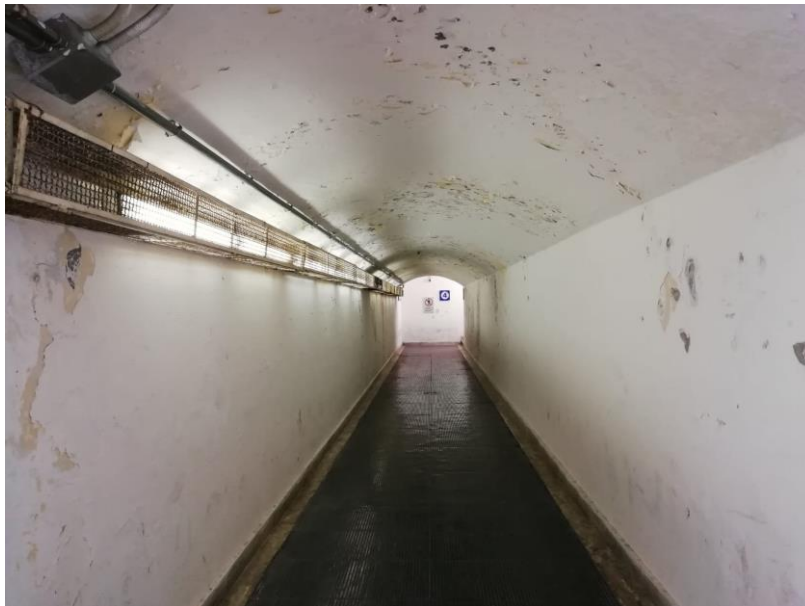
Foto 1 – Sottopasso ferroviario esistente
