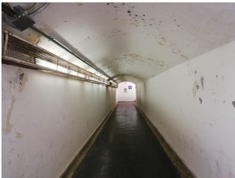
Foto 1 – Sottopasso ferroviario esistente
