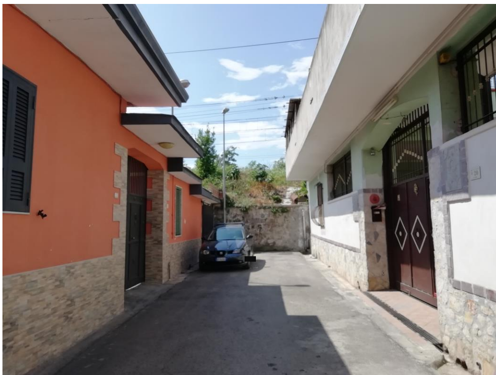
Foto 1 – vista del terrapieno ferroviario in via Garigliano
