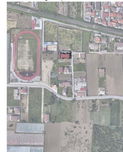
Foto aerea Google maps
